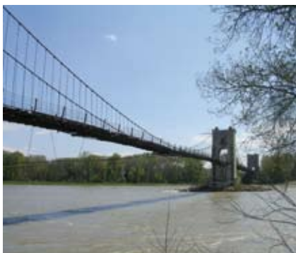
▲ Passerelle sur le Rhône à Rochemaure
