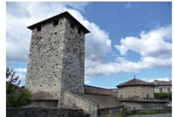
▲ Eglise Saint-Saturnin de Mélas, Le Teil
